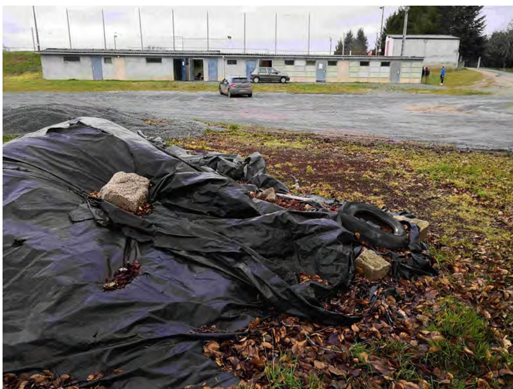
④ Les vestiaires du foot, vétustes, et devant, une future aire de camping car ?
